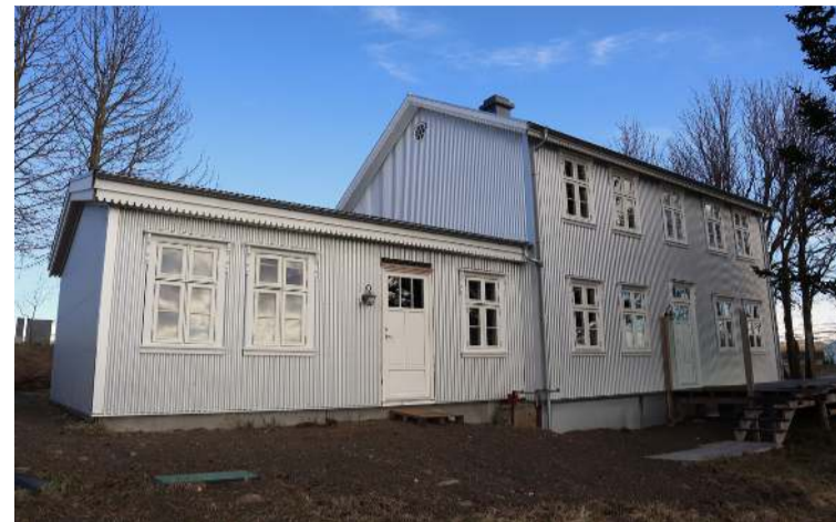
Elsta timburhús á Fljótsdalshéraði stendur á Breiðavaði og var byggt árið 1903 af langafa og -ömmu Jóhanns Gísla; Jónasi Eiríkssyni, skólástjóra Búnaðarskólans á Eiðum, og Guðlaugu M. Jónsdóttur. Það er 70 m² að grunnfleti, á tveimur hæðum með hlöðnum kjallara. Jóhann Gísli gerði það nýlega upp en þá var húsið orðið mjög illa farið. Nú er mikil þrýði að því.
